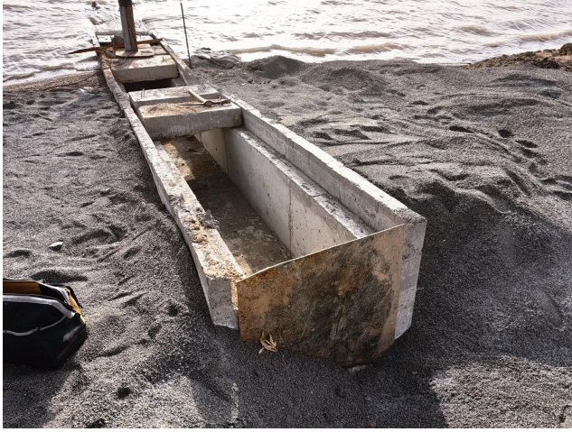
图 3.2.2.1-1 排水斜槽整体外观质量良好
