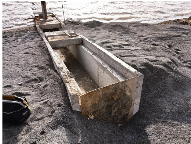
图 1 排水斜槽外观照
