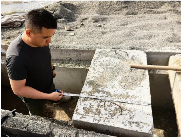
图 3.2.2.1-1 排水斜槽整体外观质量良好
