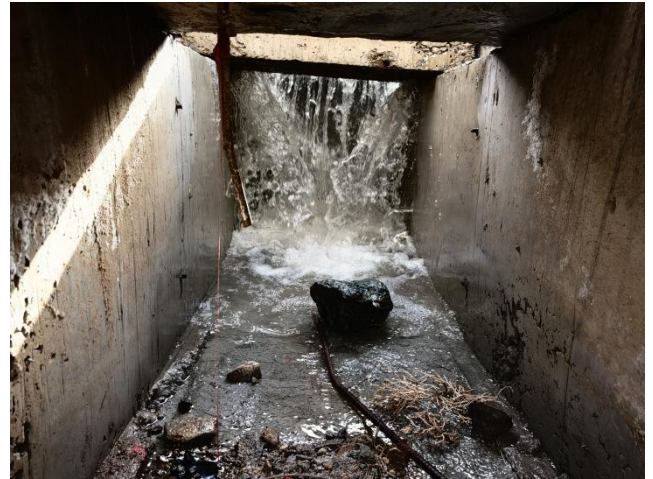
图 3.2.2.1-2 新建排水斜槽内部质量良好
