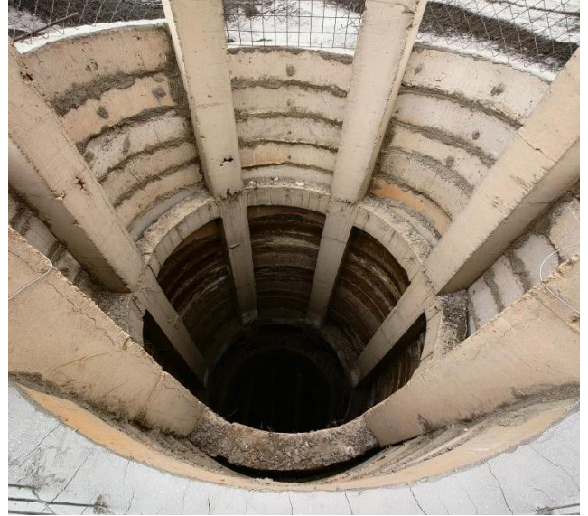
图 3.2.2-2 排水井内无淤堵、无杂物堆积
