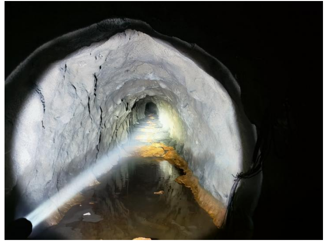
图 3.2.2-4 原排水隧洞内无淤堵、 无杂物堆积
