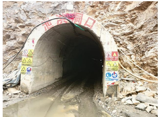
图 2 排水隧洞外观照
