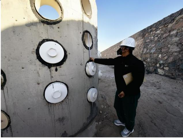
图 3.2.2-3 排水孔孔塞封堵无缝隙
