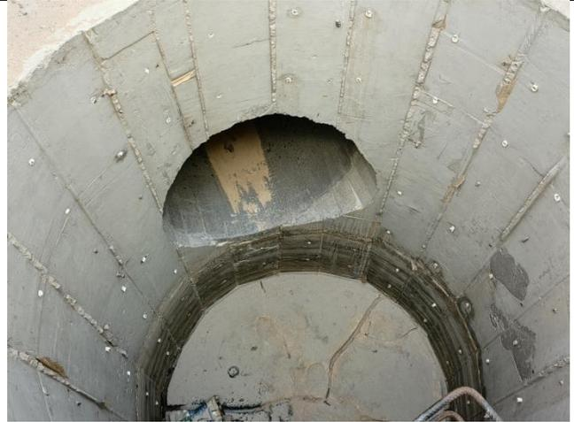
图 3.2.2-4 排水管入水口无淤堵
