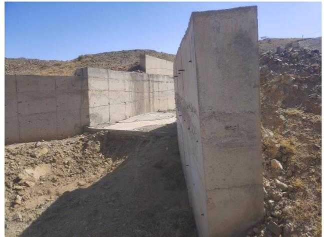
图 3.2.2-4 进水口段喇叭口开裂处侧墙倾斜
