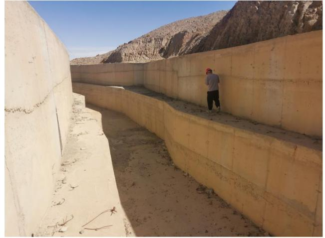
图 3.2.2-5 溢洪道内部无杂物、堵塞、淤泥
