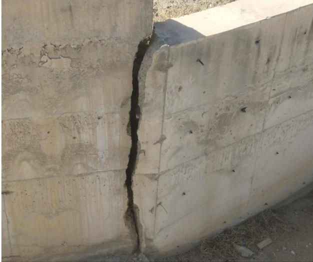
图 3.2.2-1 进水口段喇叭口与连接段连接处
