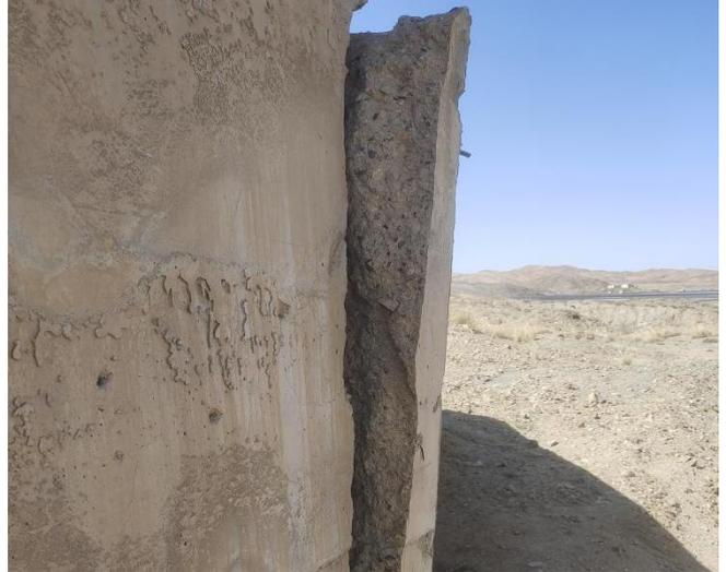
图 3.2.2-2 进水口段喇叭口开裂处侧墙脱闪
