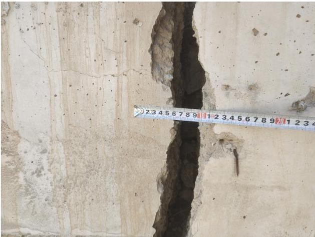
图 3.2.2-3 进水口段喇叭口与连接段连接处
