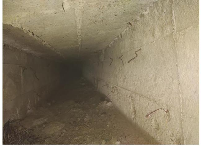
图 3.2.2-3 排水斜槽入水口无淤堵
